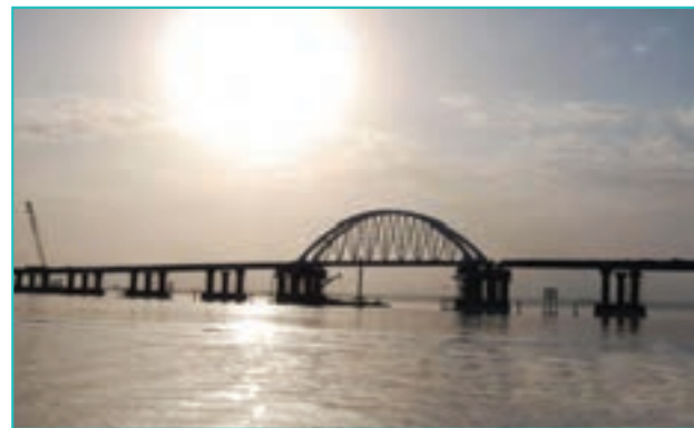
شکل ۱۲-۵- بزرگراه شهید کلانتری بر روی دریاچه ارومیه
